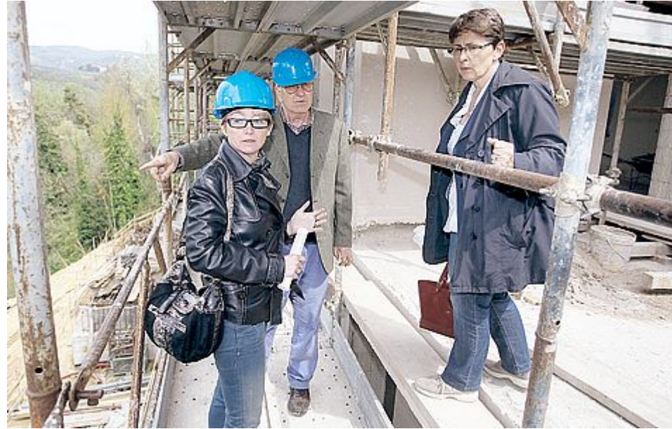
SOPRALLUOGO Il direttore lavori Ilaria Testi (con il casco) e l'assessore Gloria Testi
